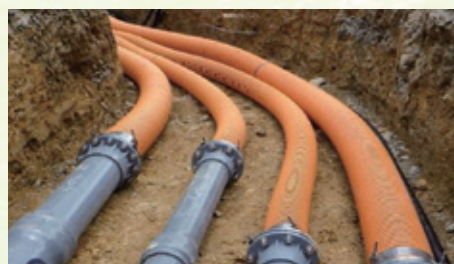
埋設のパイプライン
