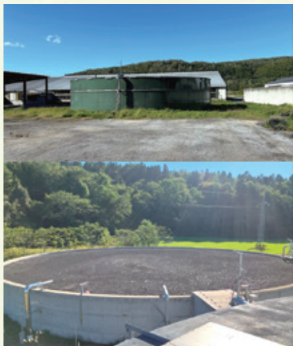
バイオ液肥貯留槽 (上・下)
