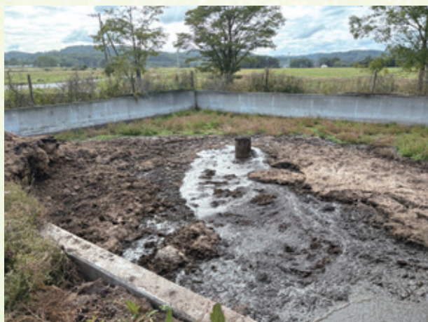
原料受け入れピット
