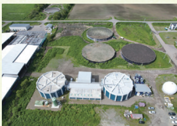
バイオガスプラント全景
