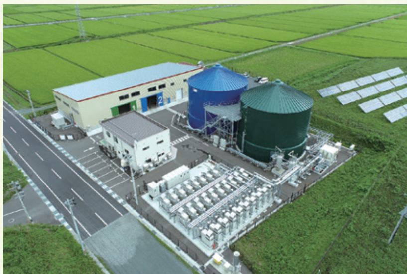
バイオガスエネルギーとわだ（B-GET）の全景
