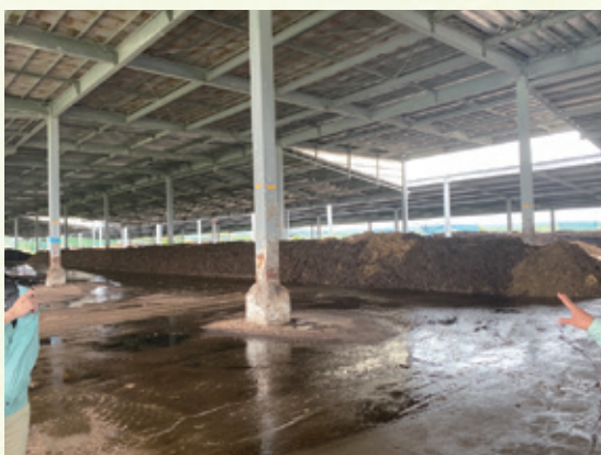
固液分離後の堆肥化施設
