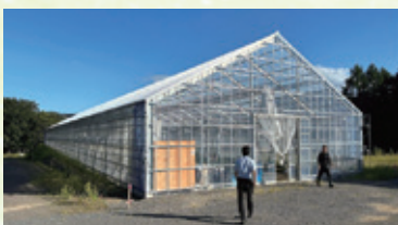
バイオガスプラント併設ハウス外観
