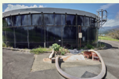
貯留槽とバイオ液肥の注入ホース
