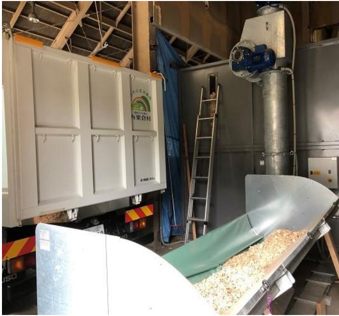
左：チップ運搬車 右：燃料投入ホッパー
