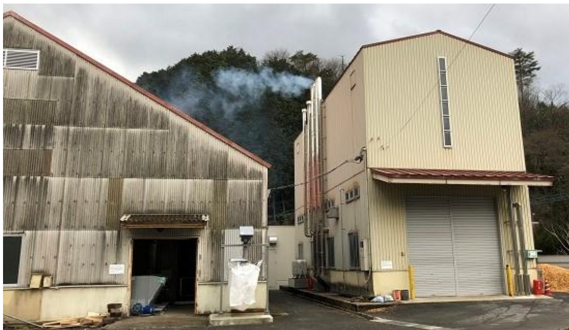
エネルギーセンター（左：ガス化発電 右：熱供給システム）
