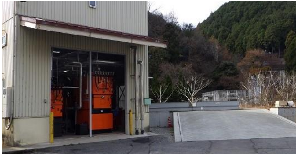
熱供給システム全景（ボイラー庫、燃料ピット）
