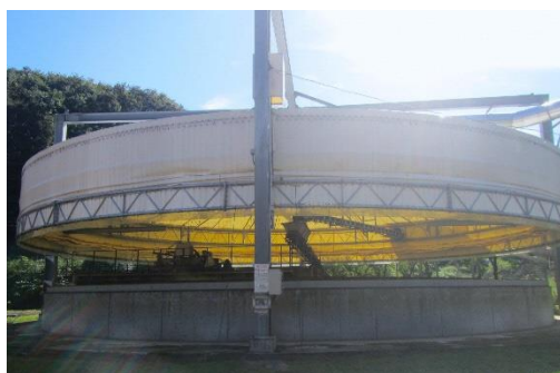
④円形発酵棟（一次発酵棟）
