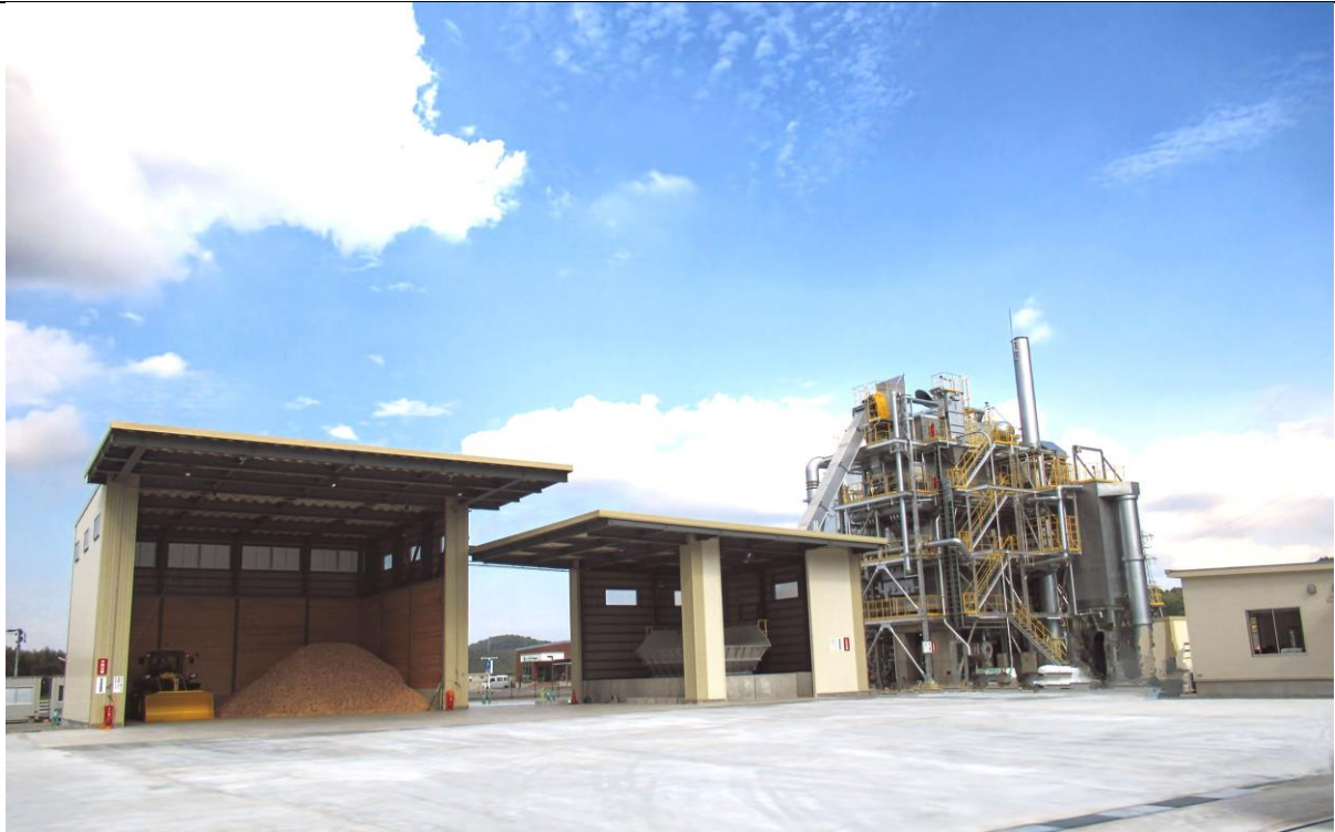
バイオマス発電所2号機を増設し稼働
