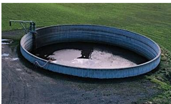
バイオ液肥貯留槽
