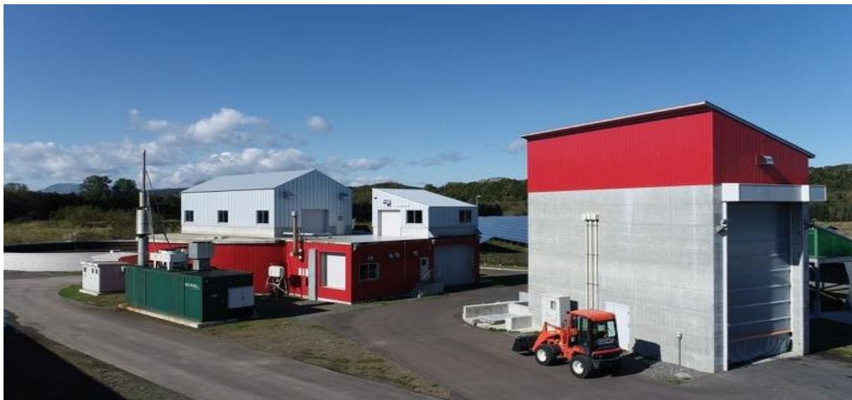
興部北興バイオガスプラント全景
