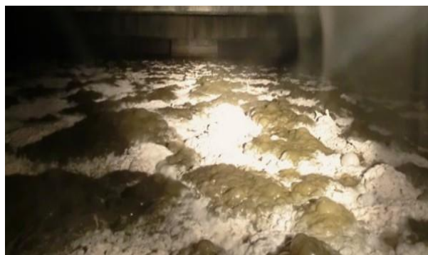
メタン発酵槽
