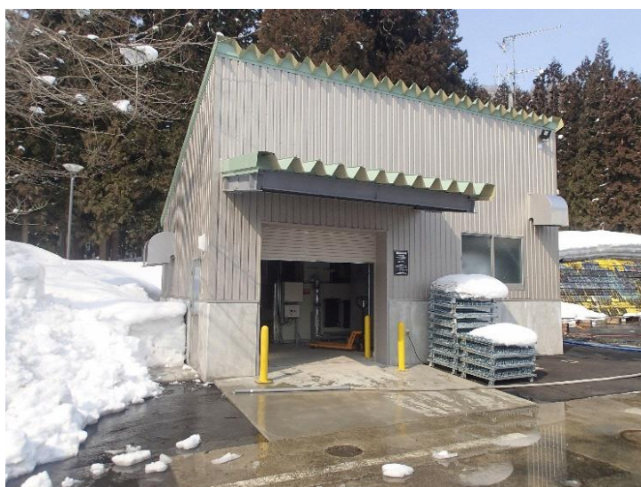
薪ボイラー施設
