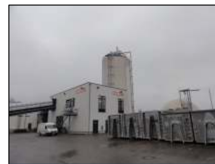
ドイツのバイオガス施設
