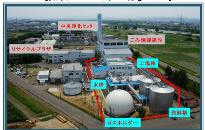
【長岡市生ごみバイオガス発電センター】
