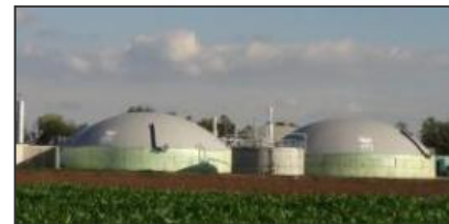
写真: 北イタリアのメタン発電施設 1000kW/h
