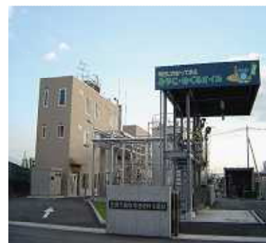
廃食用油燃料化施設
