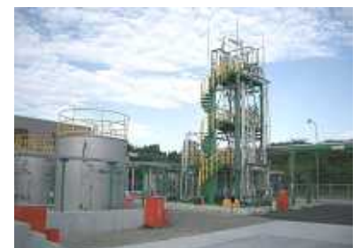
BDF 実証プラント
