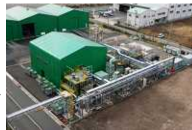
写真：食品廃棄物エタノール化設備(NEDO バイオマスエネルギー・地域システム化実験事業)
