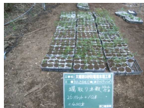
宮崎県砂防ダム工事現場における地域植生保全
